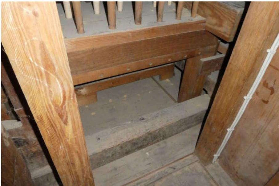
Foto Nr.: 72 Bohrmehl auch auf dem Fußboden unter der Orgel
