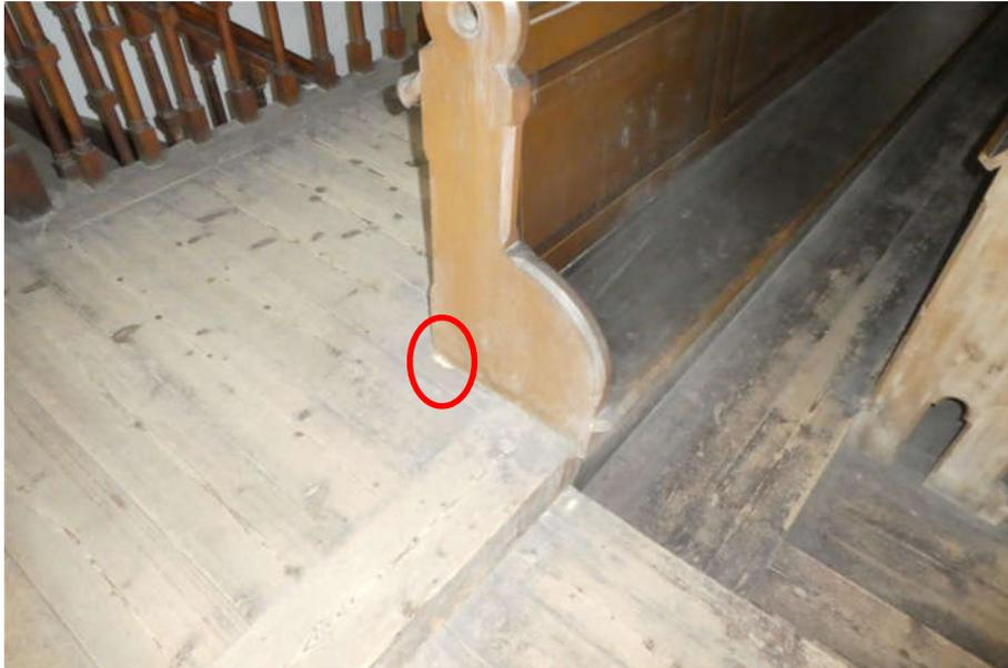
Foto Nr.: 63 Bohrmehl an Seitenteil der Bankreihe
