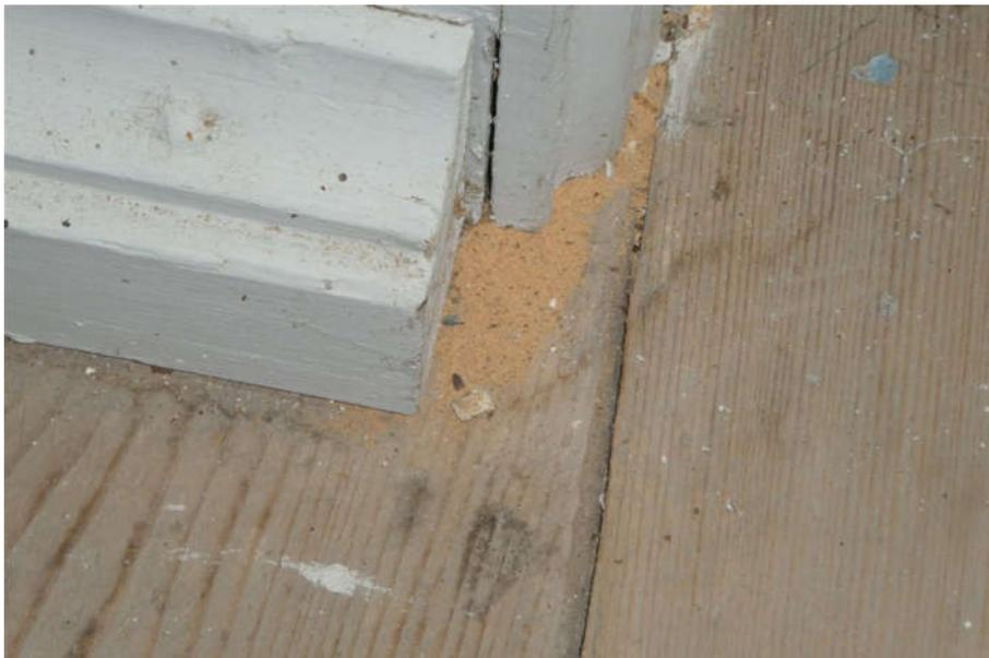
Foto Nr.: 6 Nagsel mit Schmutzbeimengung Empore
