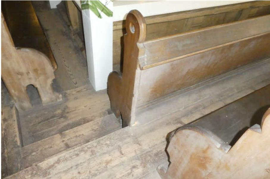
Foto Nr.: 65 Bohrmehl findet sich an fast jeder Bankreihe auch in den Emporen
