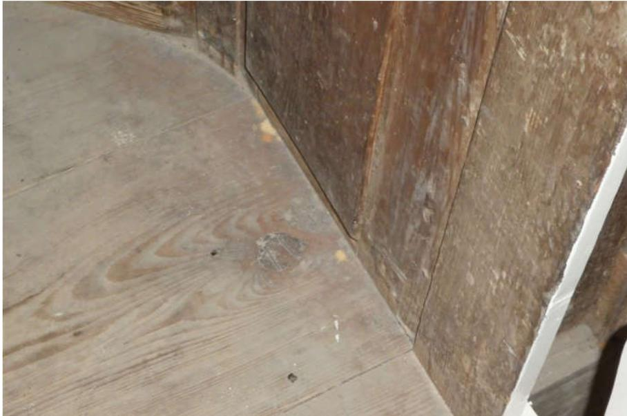
Foto Nr.: 49 ... auf dem Boden aufliegendes Bohrmehl
