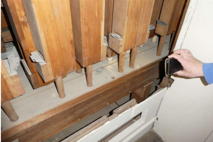
Foto Nr.: 69      sichtbares Bohrmehl zwischen Orgelpfeifen
